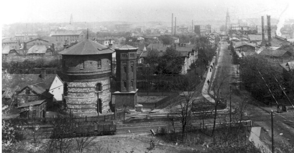
Wieża ciśnień przy ulicy Hutniczej ok. 1915 roku
