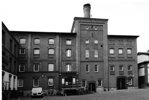
Budynek dawnej warzelni
