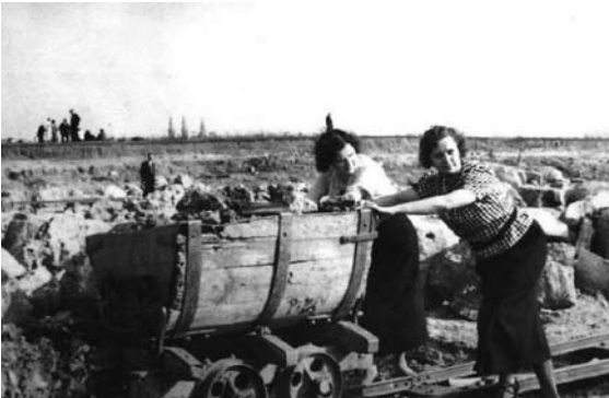
Budowa Kopca Wyzwolenia w Piekarach
