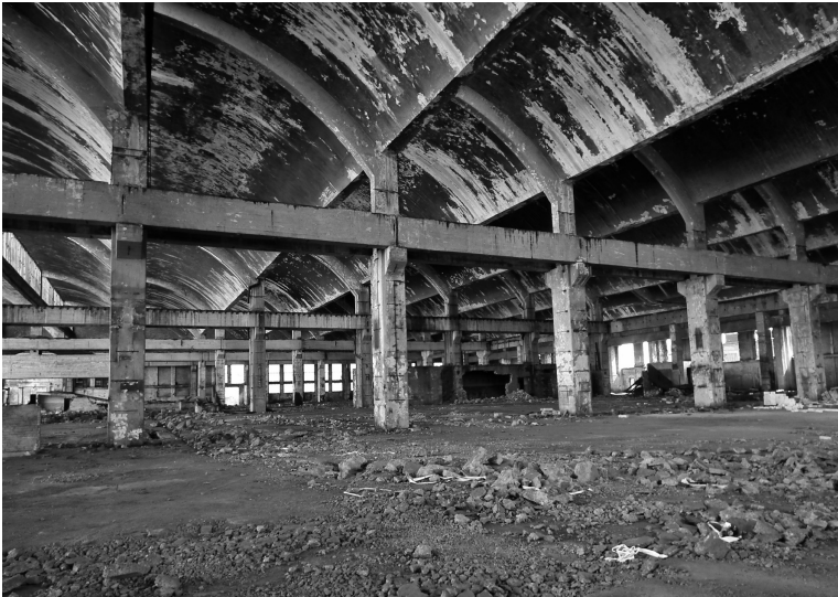
Huta „Jedność” podczas rozbiórki, 2015 r. fot. M. Derus
