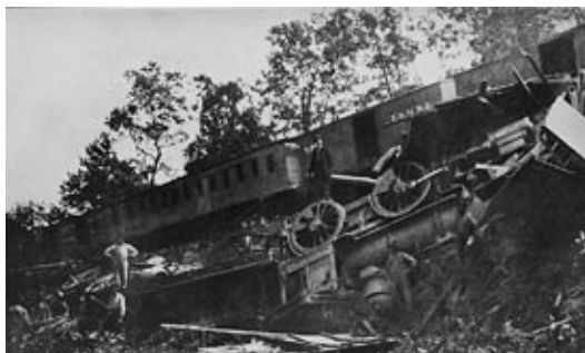
Wojna secesyjna w USA. Zniszczona trakcja kolejowa
